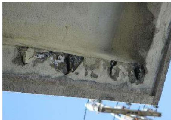
庇の一部が落下し、鉄筋がさびています。
