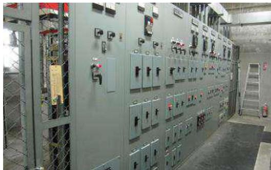
耐用年数を超過し、劣化が進んだ受電盤・配電盤です。
